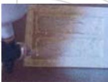
b) CSE Desactivador debe de agitarse antes de cada uso. Ahora se pinta en el mode uniformemente. Cuando se utilizan rodillos recomendamos los rodillos de pintura de lanilla y criss-cross en una capa mojado sobre mojado. Si el CSE-Desactivador se quiere aplicar con spray se debe utilizar una pistola sin aire. El balde debe de cerrarse después de cada uso.
